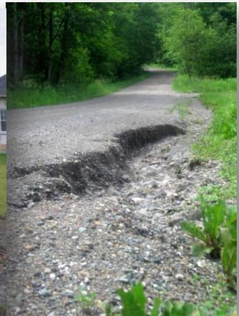
Figure 16 Érosion d'une route
