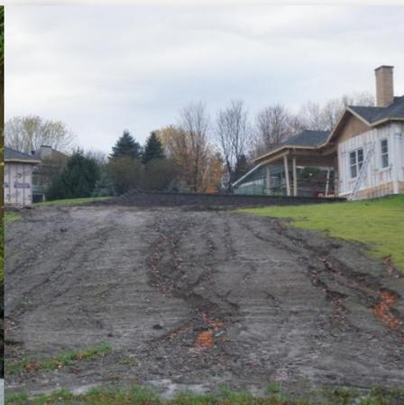
Figure 18 Érosion d'un chantier
