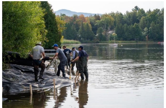
Photo APELS : Travaux d'éradication du roseau commun (phragmite) au lac Selby
